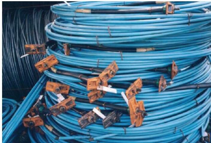
Figura 3-5 Estoque de cabos cortados e enrolados, com ancoragens pré-blocadas, devidamente etiquetados. Amarração com arame cabo a cabo. Para amarração de conjuntos de cabos deve ser usada cinta protetora para não danificar a bainha plástica
