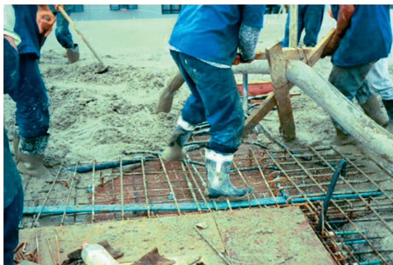
Figura 2-9 Lançamento do concreto
