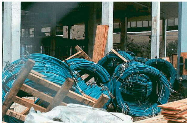
Figura 3-6 Má condição do estoque na obra dos cabos cortados
