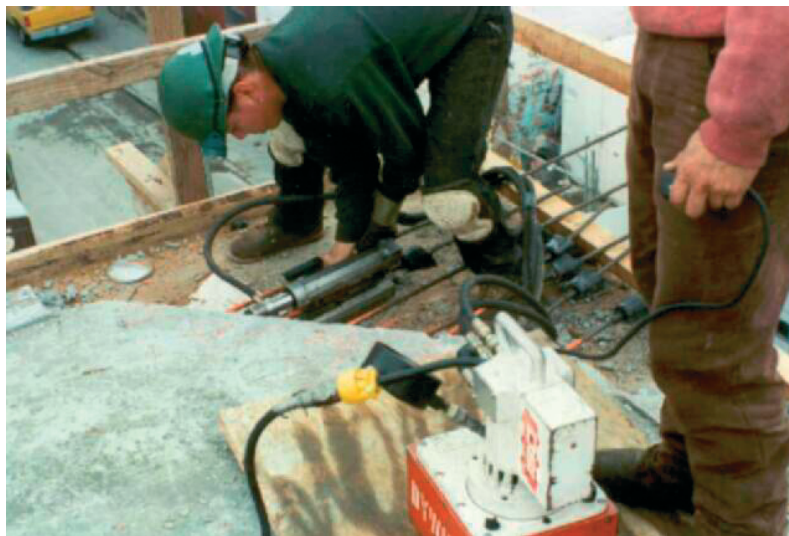
Figura 2-10 Tracionamento dos cabos
